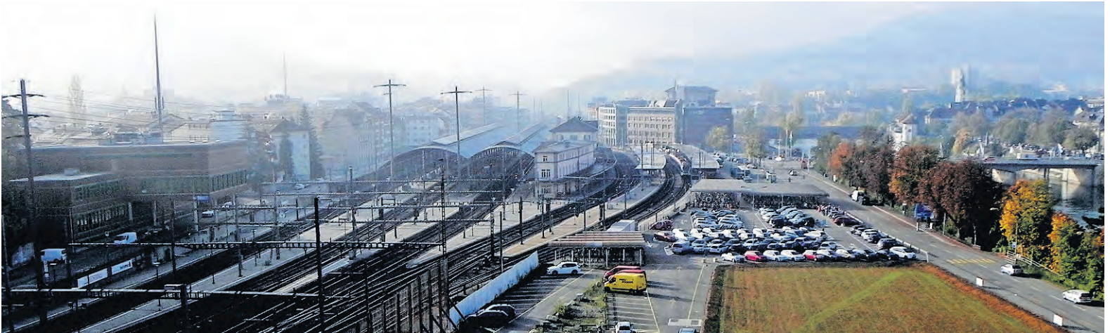
Ein neuer Blick auf Olten: Aussicht von der Terrasse der Betriebszentrale in Richtung Süden. Links ist das bisherige Zentralstellwerk sichtbar.
